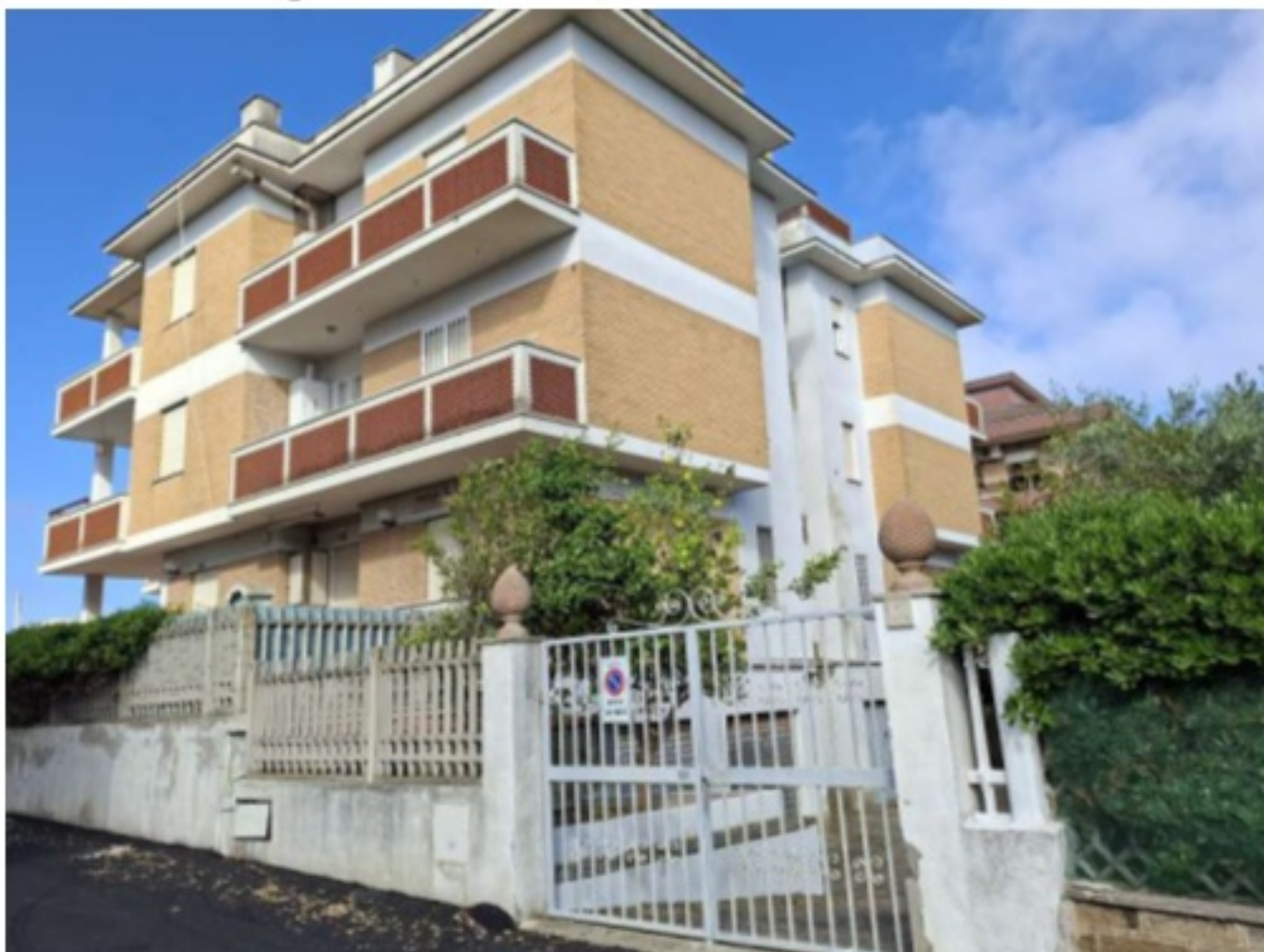
Prospetto edificio condominiale su via Pireo
