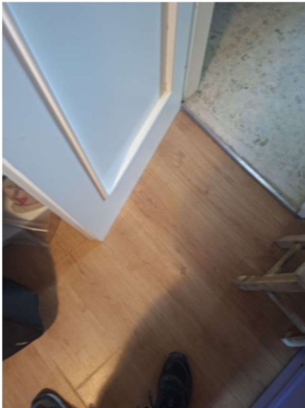
Pavimentazione in parquet su pavimentazione preesistente vano ex cucina
