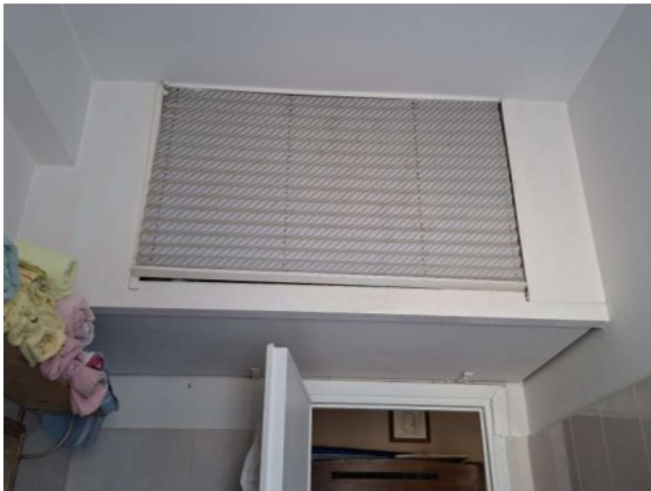
Ripostiglio in soppalco bagno
